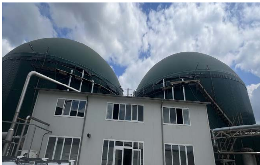
Figura 1. Imaginea foto a digestoarelor cu funcționare continuă a întreprinderii SRL “Garma Grup”.
