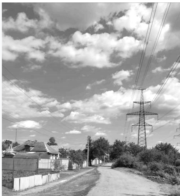
Рис.1. Жилые дома, расположенные в непосредственной близости от магистральной двухцепной ЛЭП. 1
