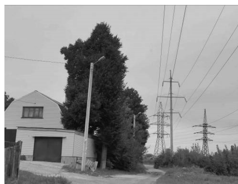
Рис.2. Жилой дом, расположенный вблизи двух двухцепных ЛЭП. 2
